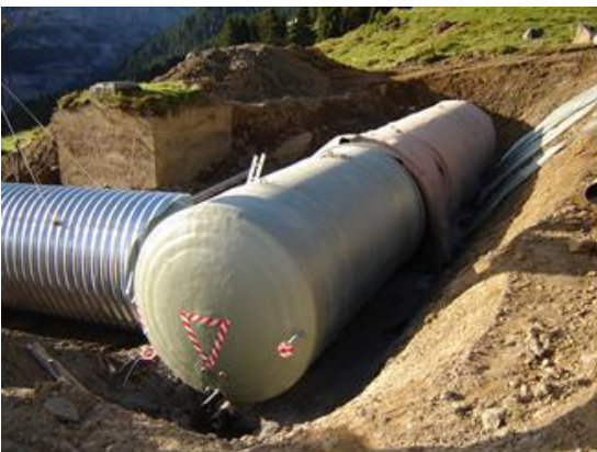
Reservoir vor dem Eindecken
